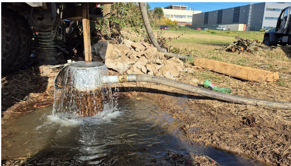
Obr. 1 Realizace likvidačních prací zhavarovaného vrtu VP9507 Lanškroun.
